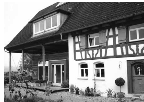
Abb. 2: Modernisierung des Wohnanteils eines ortsbildprägenden Bauernhauses aus dem Jahr 1755 und Neubau in einer Box unter dem ehemaligen Scheunendach des Wirtschaftsteils für die Nutzung als Friseursalon (Herbertingen-Mieterkingen, Landkreis Sigmaringen, Baden-Württemberg), Foto: Privat
