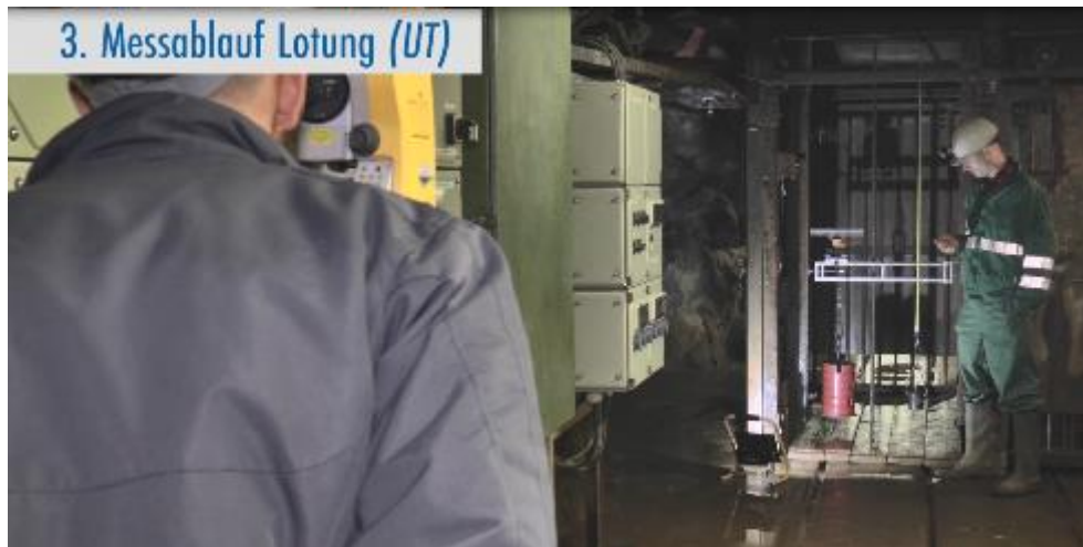
Abb. 3: Schachtlotung Messablauf untertage (Quelle: TU Bergakademie Freiberg)
