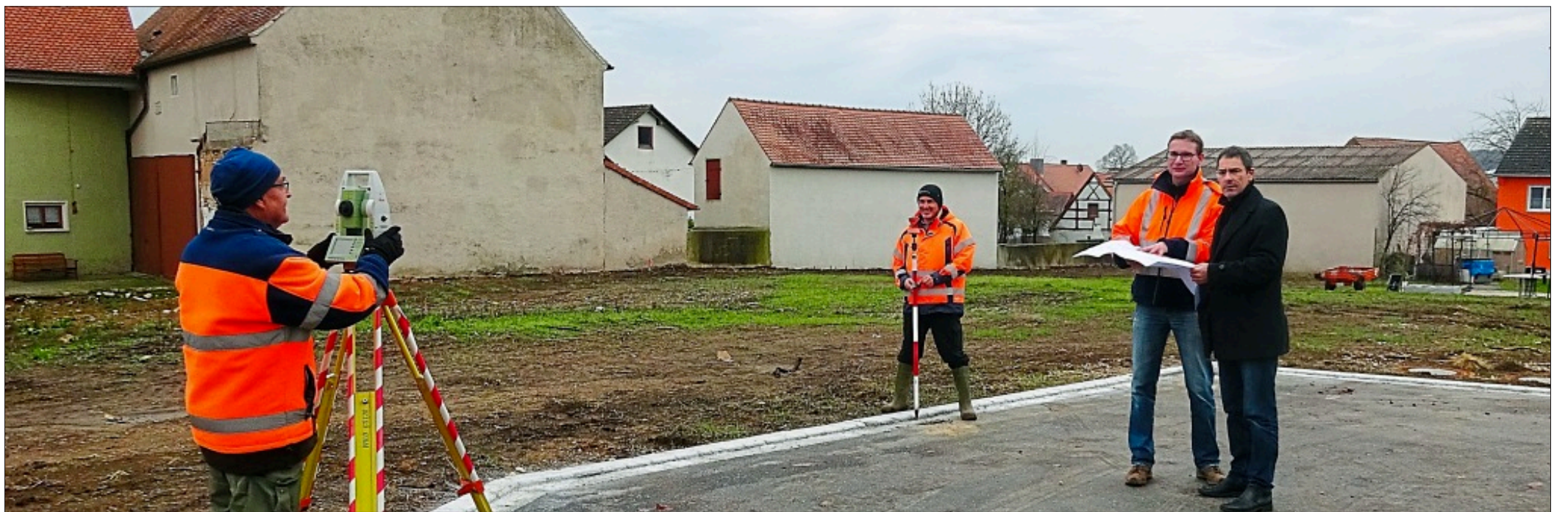
Vom Ruinengelände zum lebendigen Ortsquartier: In Dittenheim im Altmühltal war der Bauzustand eines nicht mehr bewohnten Bauernhofs so schlecht, dass er abgerissen werden musste. Im Rahmen der Dorferneuerung wurden in dem Ort im Landkreis Weißenburg-Gunzenhausen fünf neue Bauplätze ausgewiesen. Foto: Bayerisches Staatsministerium für Ernährung, Landwirtschaft und Forsten
